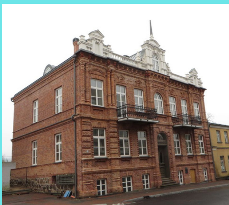
Pastatas Telšių r.
