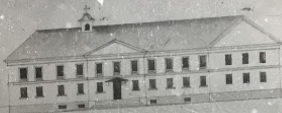
Ansicht von der Südseite
